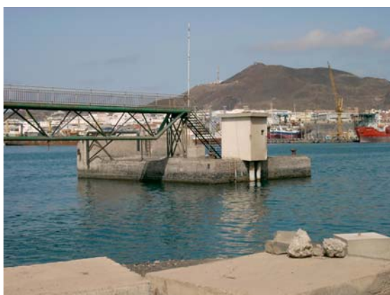
Vista general del emplazamiento de la caseta del mareógrafo.
